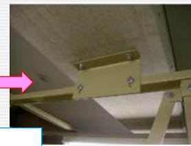
従来の「点」で支えていたボルトに加え 「面」で支えるボルトを追加
