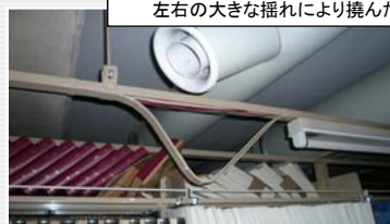
左右の大きな揺れにより撓んだ配線バー
