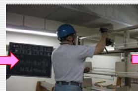
従来の「点」で支えていたボルトに加え 「面」で支えるボルトを追加
