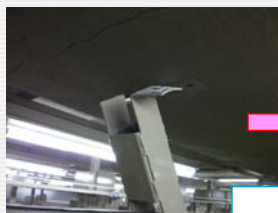
従来の「点」で支えていたボルトに加え 「面」で支えるボルトを追加
