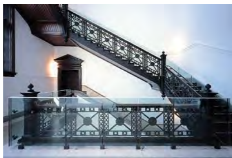
大階段2階部分。階段の裏側にはフローリング材が張られている。鋳鉄製の既存の手摺の内側にガラスの手摺を取り付けている。
