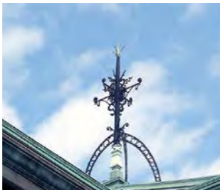
元は鋳鉄製であったものをアルミで作り直した避雷針。
