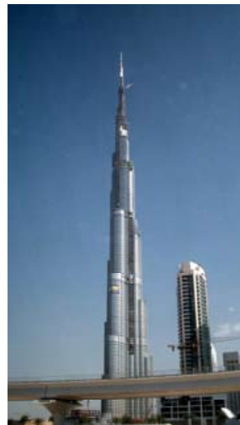
写真1 建設が進むブルジュ・ドバイ
